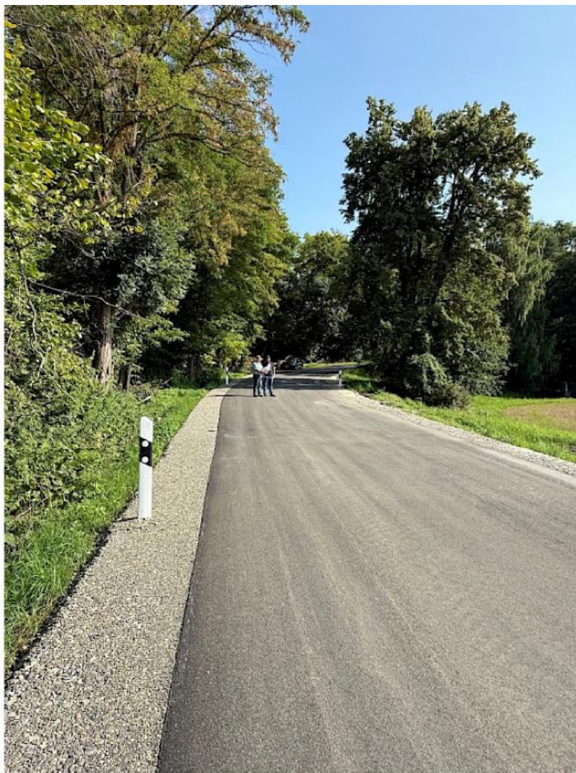
Im Bild Bürgermeister Carsten Joneitis mit Bauamtsleiter Julian Heyse bei der Abnahme der Gemeindeverbindungsstraße.
